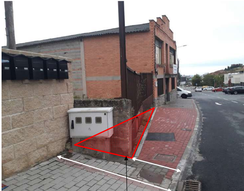
Fachada norte de la parcela
